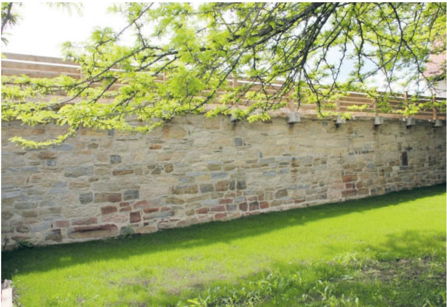
Das Baustellengerüst ist abgebaut, die Baufirma ist abgerückt, der Rasen im Kirchgarten wächst nach. Die Sanierung der Wehrmauer konnte kürzlich abgeschlossen werden. Durch diese Maßnahme wurden nicht nur im Mauerwerk Schäden beseitigt, auch die Oberseite der Mauer wurde durch neu verlegte Steinplatten vor eindringendem Wasser geschützt. Damit konnte eine aufwändige und durch Baulärm und Staub die Nachbarschaft belastende, nicht alltägliche Baumaßnahme erfolgreich abgeschlossen werden.
