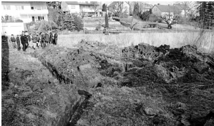
Das verunreinigte Erdreich wurde ausgebaggert und zu einer geeigneten Deponie zur Untersuchung und weiteren Behandlung transportiert. Dazu musste das Lagergebäude des Heizölhändlers komplett abgerissen werden. Die entstandenen Gruben wurden wieder mit nicht verschmutztem Erdreich verfüllt. Insgesamt wurden rund 2.400 t verunreinigter Boden ausgehoben und ordnungsgemäß entsorgt.
