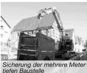
Sicherung der mehrere Meter tiefen Baustelle
