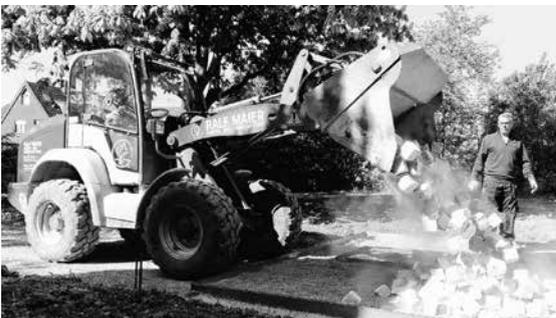
Die Granitpflastersteine mit oberseitig gesägt und gestrahlter Oberfläche werden mit der Radlader vor Ort gebracht
