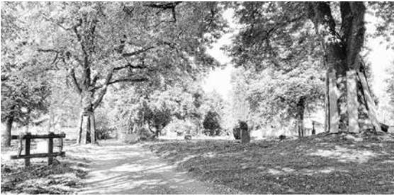
Die grobe Erdplanie ist hergestellt, Wege sind eingeschottert für die anstehenden Asphaltarbeiten. Bestandsbäume sind mit Dielen vor Beschädigungen durch Baumaschinen geschützt.
